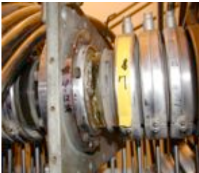
写真1. 破損したガラス製のコラム
